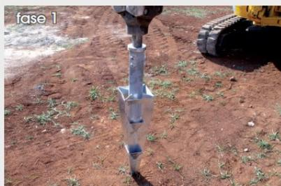
Inizio dell'operazione di posa del micropalo, eseguibile con un normalissimo escavatore dotato di martello pneumatico (il battipalo Unistab è adattabile ad ogni tipo di martello pneumatico).
