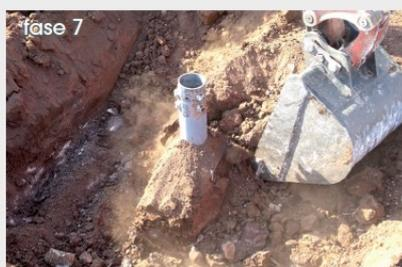
Talvolta la rimozione del micropalo non risulta possibile tramite lo stativo a causa dell'eccessiva resistenza opposta alla fuoriuscita dal suolo.
